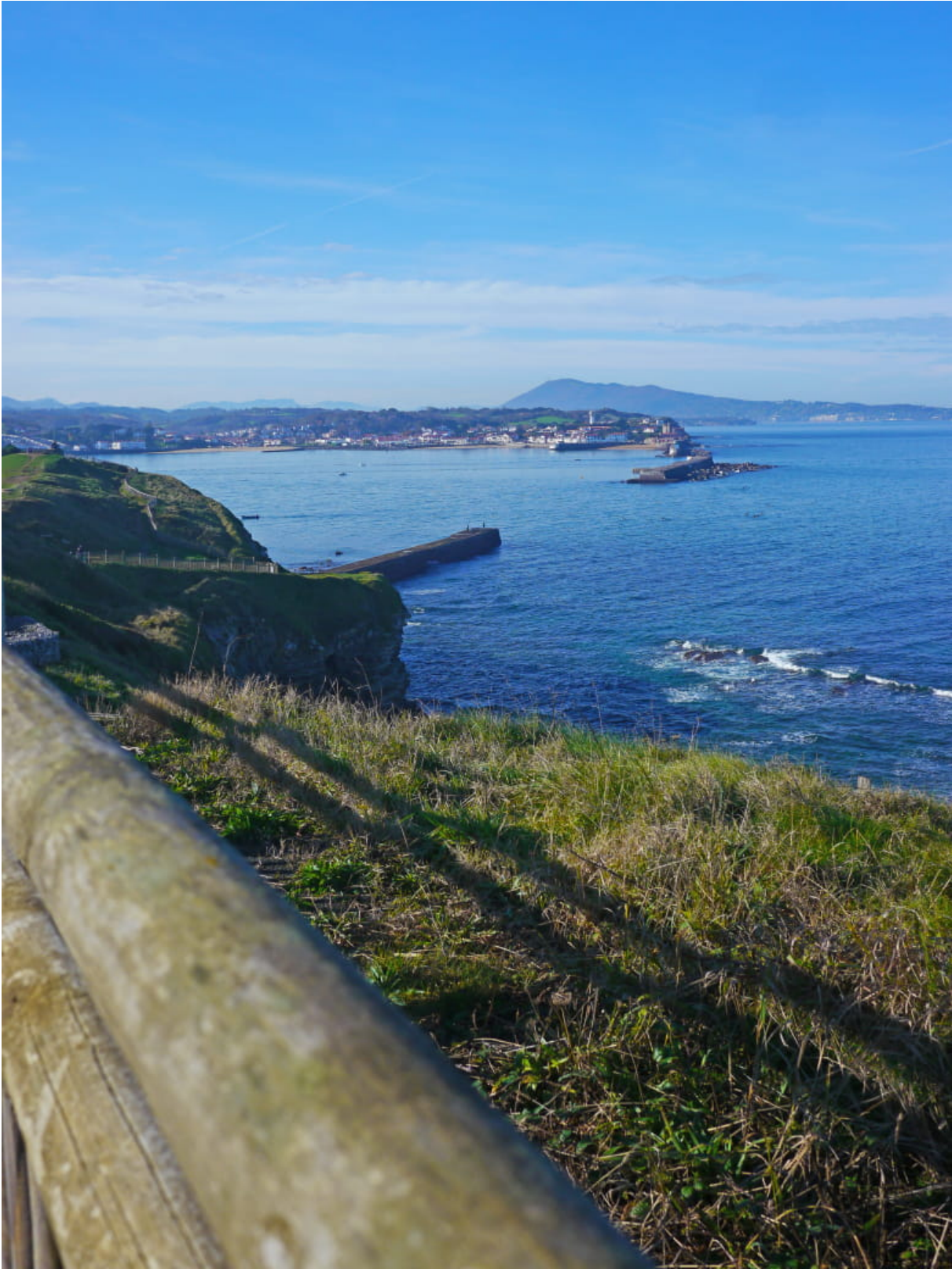
Photo digues de la baie
